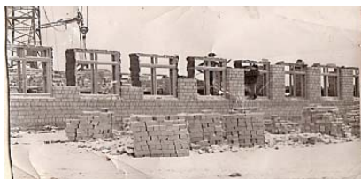
Строительство первого этажа здания новой школы, 1964 год
